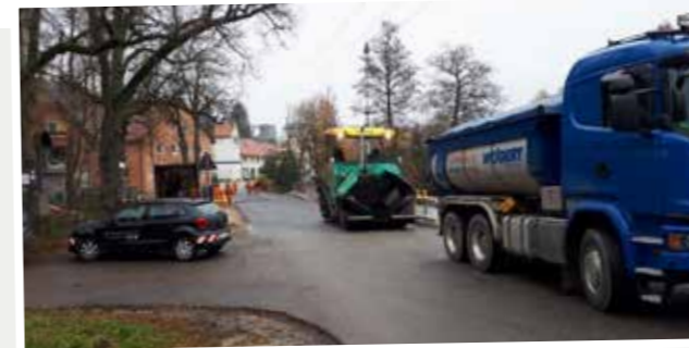
Die Sanierung der Brücke Hammermühle wurde zum Jahresende 2019 abgeschlossen. Die Kosten der Maßnahme beliefen sich auf ca. 280.000 €.
